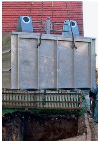
Entladen, positionieren und einsetzen: Eine Unterflur-2er-Einheit mit Stahlwanne.
