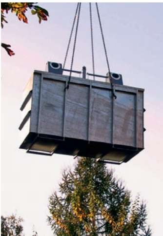
Entladen, positionieren und einsetzen: Eine Unterflur-2er-Einheit mit Stahlwanne.
